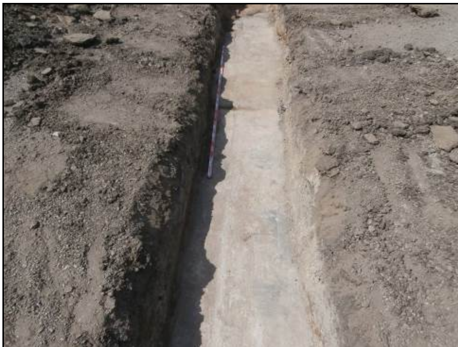
Fotografia 35: Detall del paviment UE 2000 en el tram menys deteriorat.
