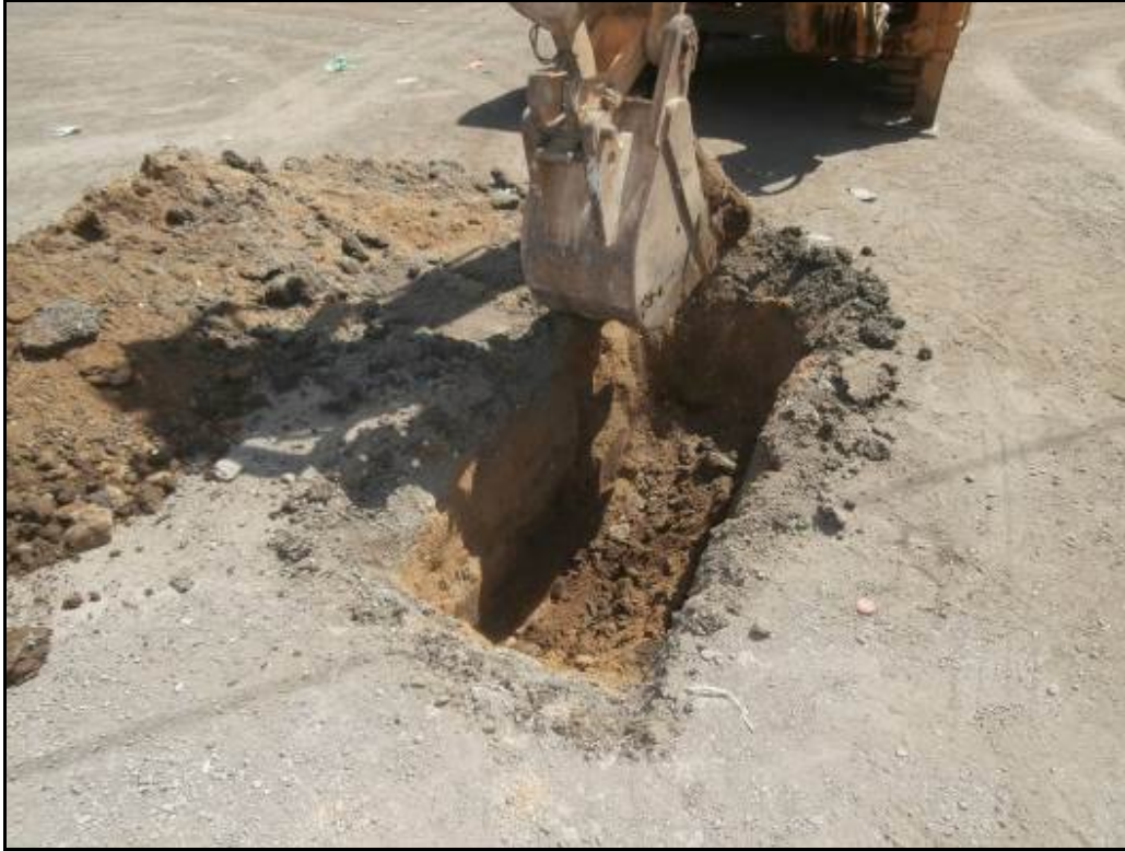
Fotografia 7: Inici d'excavació de la cala 5.
