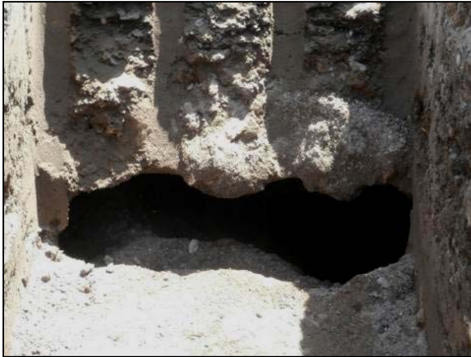
Fotografia 27: R-1. Vista lateral de la UE 1008, amb l'interior buit.
