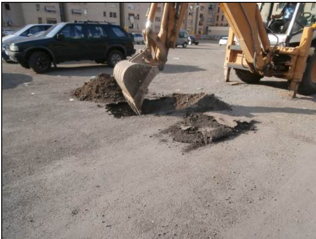
Fotografia 3: Inici dels treballs d'excavació de la cala 1.
