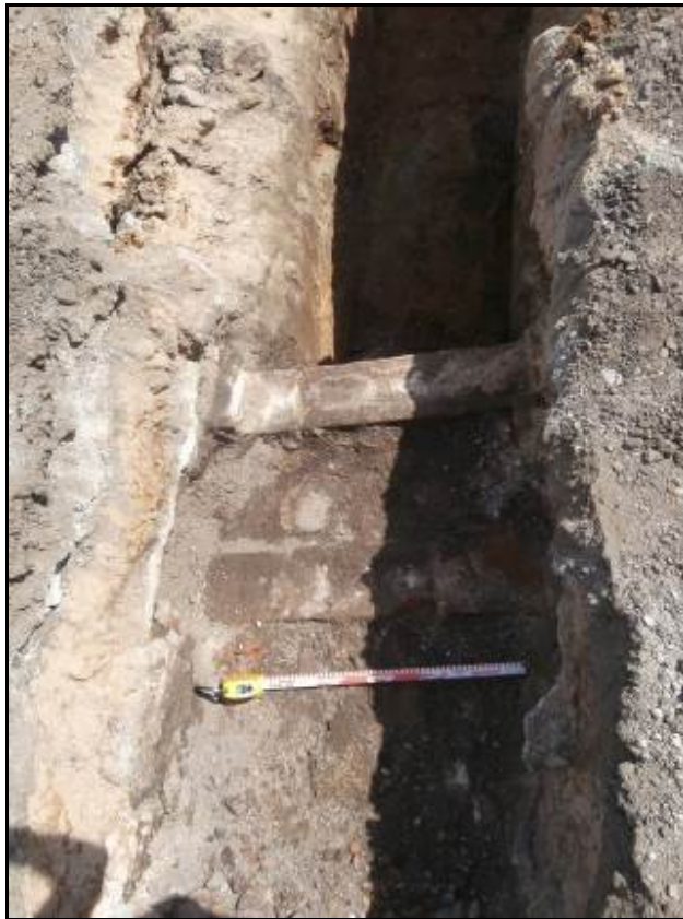
Fotografia 43: R-2. Vista zenital de la canalització UE 2007.
