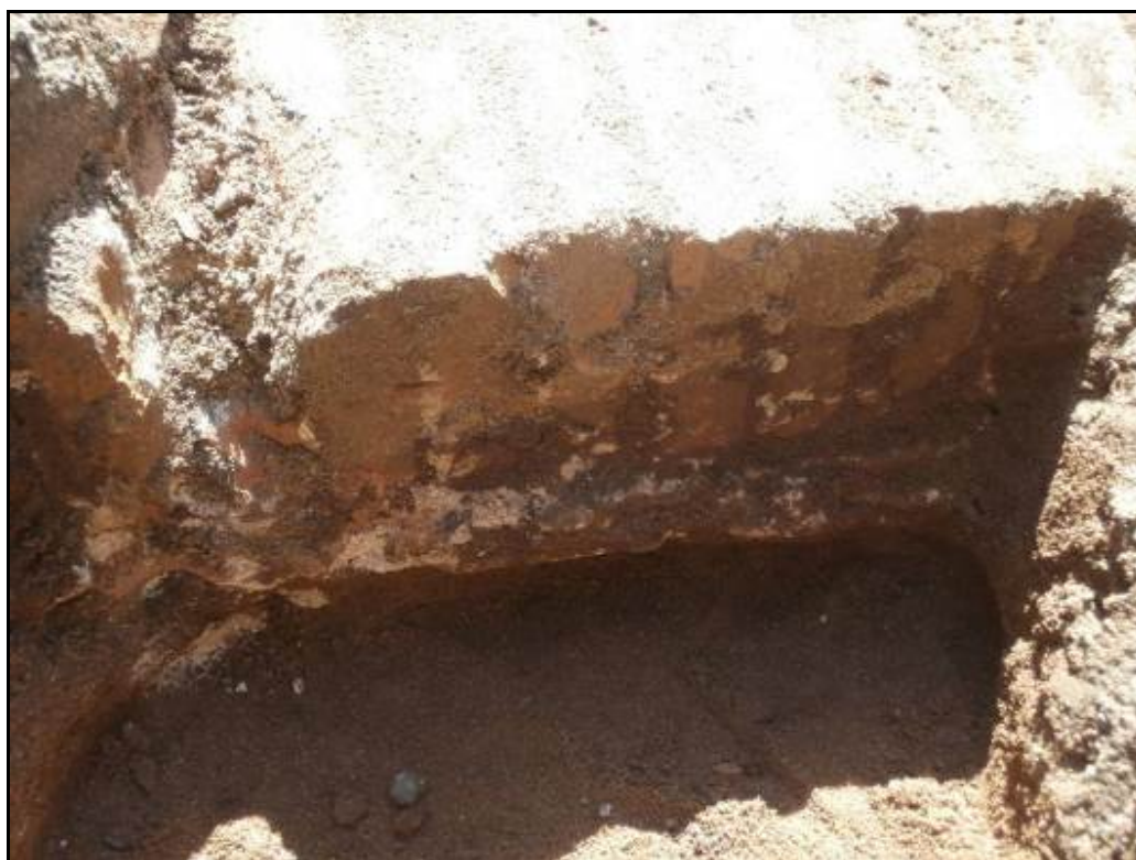
Fotografia 20: C-7. Detall de l'alçat del mur UE 701.
