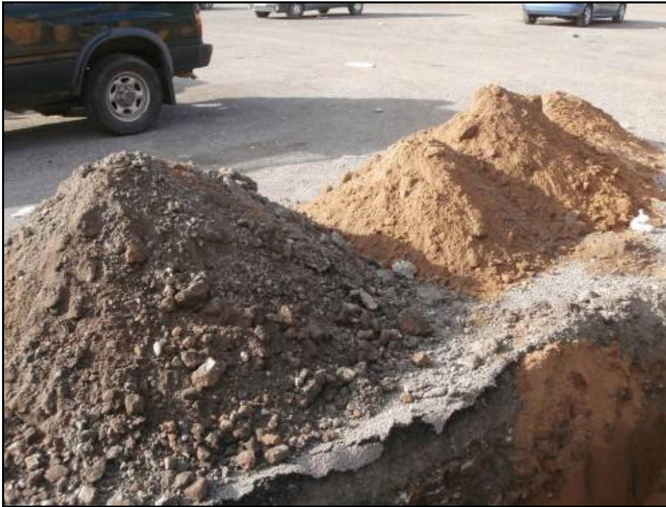
Fotografia 5: Sediments extrets de la cala 1, UE 1 i 2 en el primer pla, i UE 3 (sorres) al fons.
