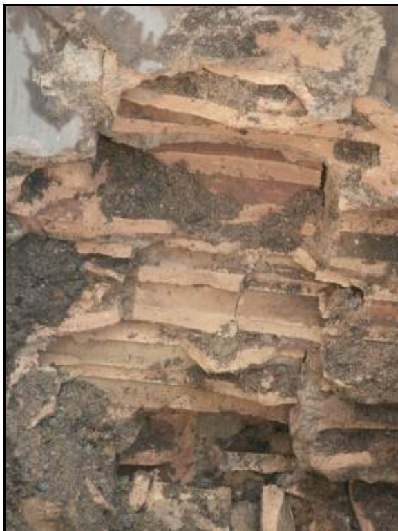
Fotografia 15: Detall de la paret NW del dipòsit UE 301, obrada amb maons buits.
